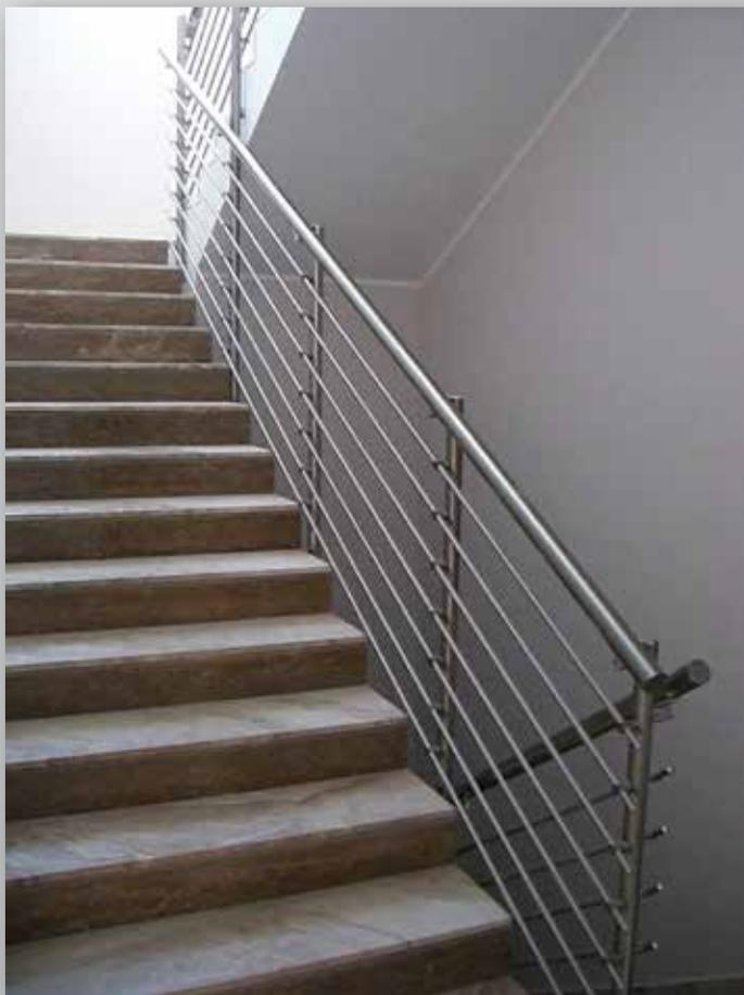
Passamano realizzato con profile di alluminio a sezione circolare diametro 50 x 2 mm o rettangolare 30 x 80 mm accessorio snodato di collegamento, tra piantone e passamano, realizzato in alluminio adattabile a qualsiasi pendenza.
